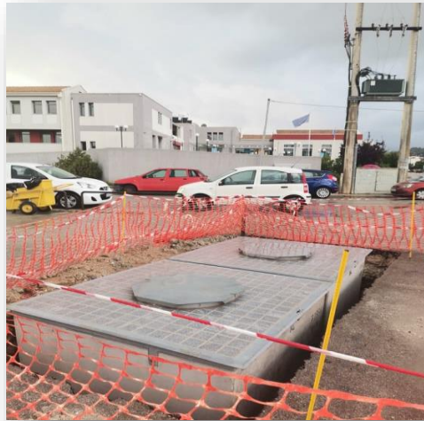
Εικόνα 7: Τοποθέτηση Υπόγειων Κάδων
