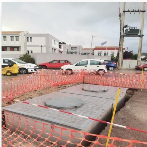
Εικόνα 7: Τοποθέτηση Υπόγειων Κάδων
